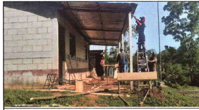
Foto 6: sustitucion de piso del corredor y desmontaje de puertas y ventanas.
