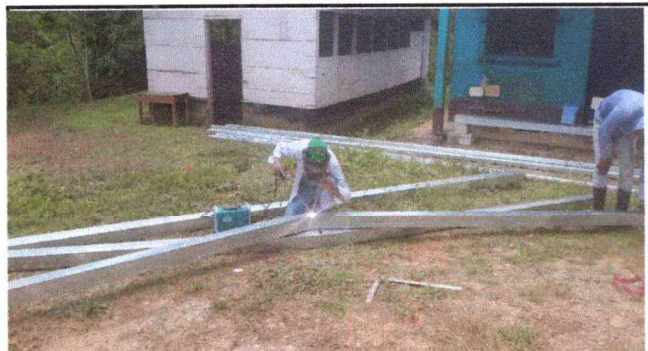
Foto 3: Proceso de soldadura de costaneras, en la comunidad Yalchacti.
