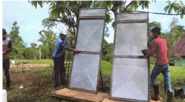
Foto 4: Construccion de Puertas de metal a medida en la EORM.
