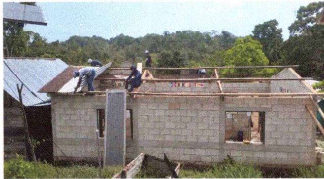
Foto 2: Desmontaje de laminas de aula principal.
